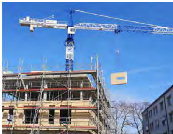
Der Neubau steht zwischen zwei Gebäuden der ehemaligen Leighton Baracks, die heute vom Mathematischen Institut genutzt werden. Links zu sehen ist der Einbau der vorgefertigten, elementierten Fassade in Holztafelbauweise.
