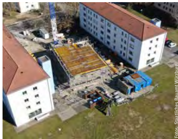
Der Neubau steht zwischen zwei Gebäuden der ehemaligen Leighton Baracks, die heute vom Mathematischen Institut genutzt werden. Links zu sehen ist der Einbau der vorgefertigten, elementierten Fassade in Holztafelbauweise.
