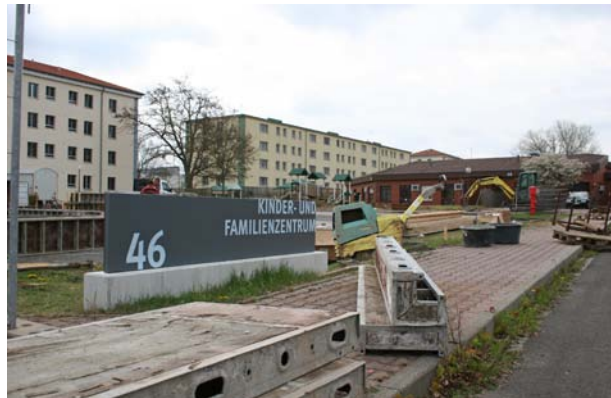
Auf dem Parkplatz vor dem künftigen Kinder- und Familienzentrum hat der Aufbau der mobilen Raumsysteme für die Kinderbetreuung begonnen. Foto: Georg Kaiser
