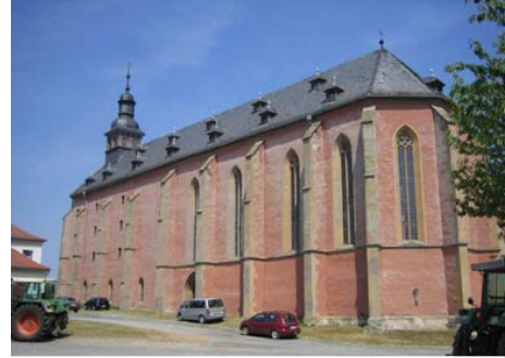
Die Kirche Mariaburghausen wird derzeit umfangreich saniert. Die Kosten dafür betragen rund 100.000 Euro. (Foto: Universität Würzburg)
