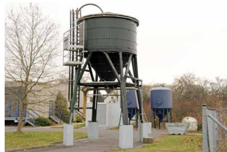
Hier lagern die Salzvorräte der Uni: in dem großen Silo im Vordergrund und in den beiden blauen Behältern hinten.
