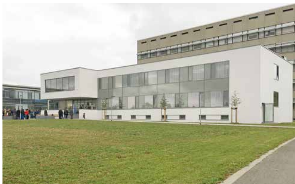
Der Neubau des Zentrums für Nanosystemchemie auf dem Hubland-Campus wurde im direkten Anschluss ans Chemiezentrum gebaut.
