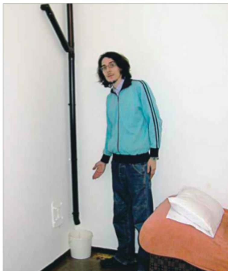
Baumängel an Würzburger Unigebäuden: »Entwässerung« eines undichten Flachdachs (links), Abstützen eines maroden Tiefgaragenträgers.
