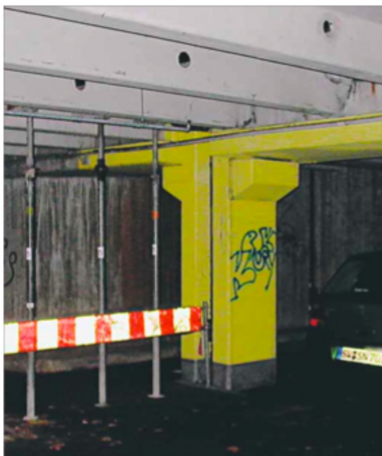
Baumängel an Würzburger Unigebäuden: »Entwässerung« eines undichten Flachdachs (links), Abstützen eines maroden Tiefgaragenträgers.
