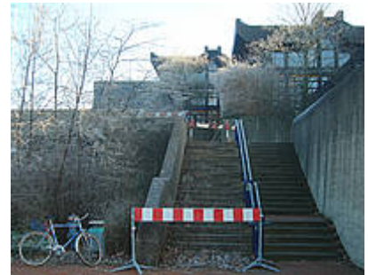
Mehr Geld für den Bauunterhalt fordern Würzburgs Studierende vom Freistaat. Schließlich seien zahlreiche Gebäude in schlechtem Zustand. (Foto: Andreas Hanka)
