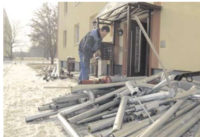
Der Umbau läuft auf Hochtouren: Arbeiter entkernen Gebäude auf dem Leighton-Areal.
